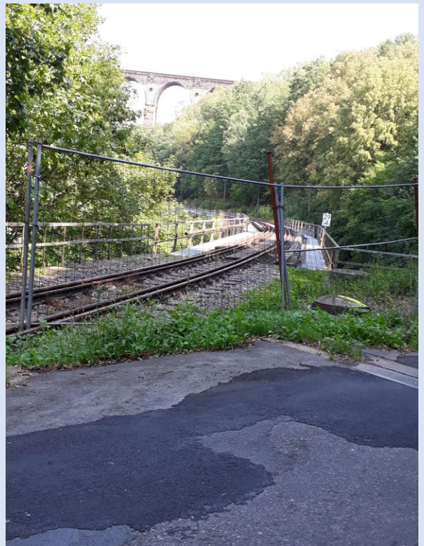
Abgesperrtes Teilstück der Muldentalbahn bei Cossen
