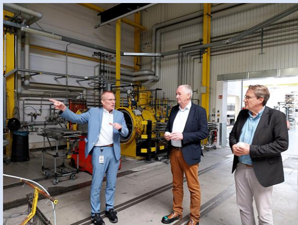
Große Kunden und große Herausforderungen: Cotesa-CEO Falko Löhr erläutert Thomas Schmidt und Oberbürgermeister Ralf Schreiber (v.l.n.r.) die Produktionsabläufe in der Abteilung mit den Autoklaven (luftdicht verschließbare Druckbehälter – siehe Hintergrund). Das Unternehmen beliefert die großen Akteure der Luftfahrt, aber auch den Automobilbau, mit Faser-verbundstoffteilen. Insgesamt befinden sich rund 6500 Produkte im Portfolio, von denen viele selbst entwickelt wurden.
